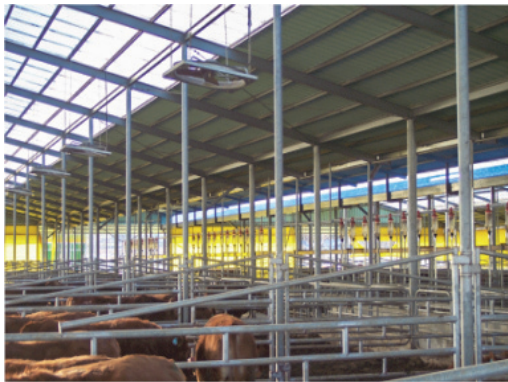
〈그림 9〉 사각 송풍팬 설치
