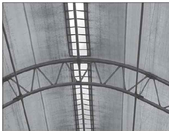
<그림 6-7> Hoop structure의 지붕 환기시설(예)
