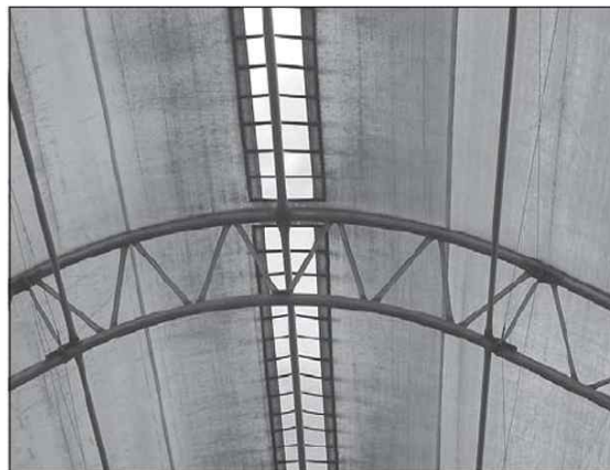
<그림 3-6> Hoop structure의 지붕 환기시설(예)
