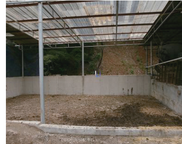
▲ 벽면을 콘크리트로 시공한 퇴비사
