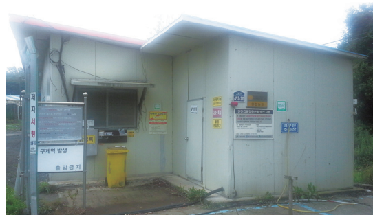
▲ 축사 출입구에 건물을 이어붙인 대인 소독시설 및 외부물품 창고
